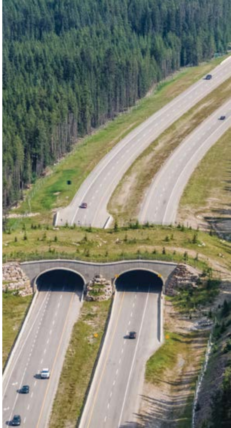
Efforts pour améliorer la connectivité au parc national Banff par l'entremise d'un passage supérieur dans le parc permettant à la faune de traverser la route transcanadienne en toute sécurité.
